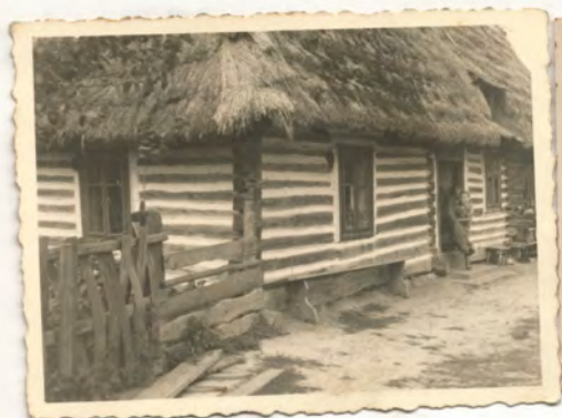
Wohnhaus von Dalen
